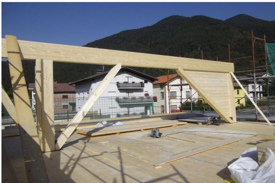
Telaio su primo solaio X-lam 200 mm
