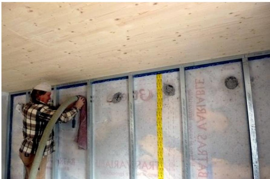
Insufflaggio cellulosa alta densità 80 kg/mc
