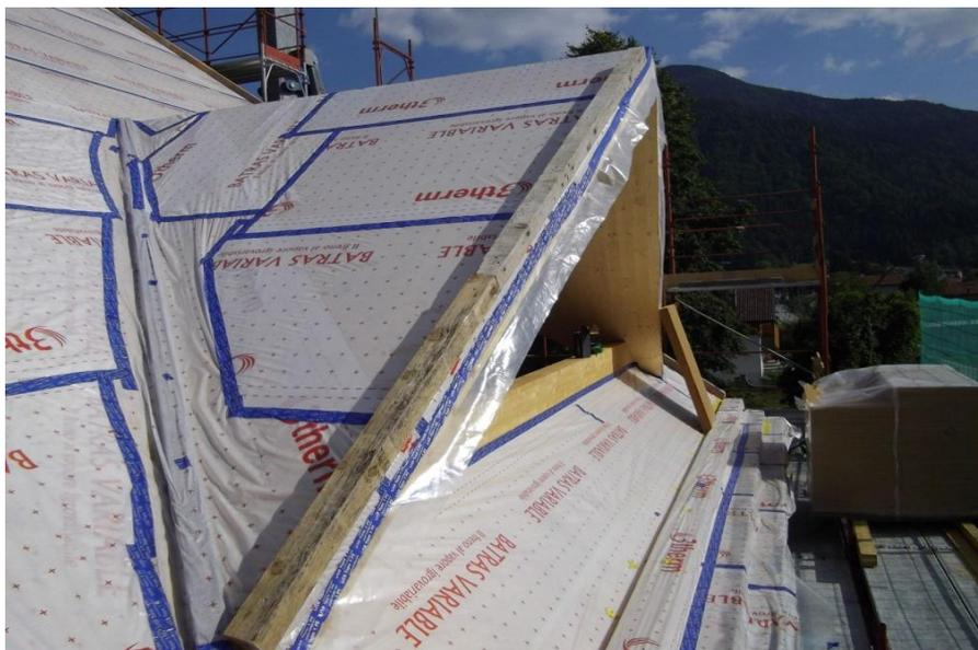
Freno vapore ed isolamento 180 mm
